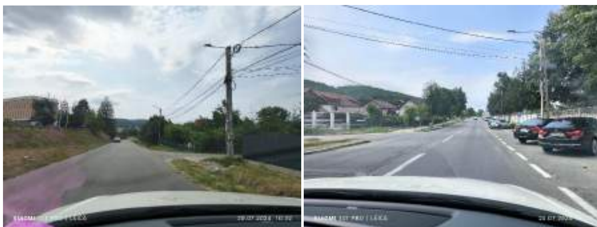
Figură 18-Trotuare in stare necorespunzatoare
